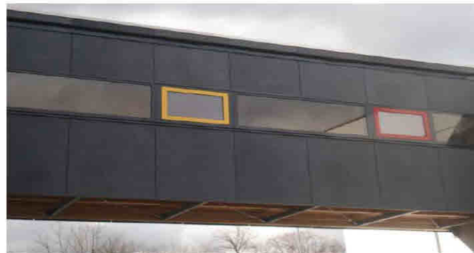
unten: mineralit®- Fassadenplatten an Laubengang; anthrazit
