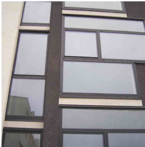
Fassade mit mineralit®- Streifen als Gestaltungselemente
