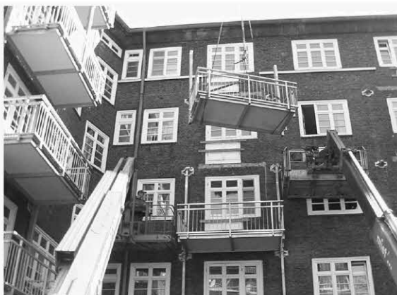
L'élément pour balcon est monté sur l'ancrage préparé dans le mur.
