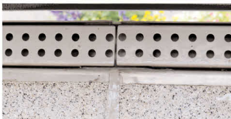
le caniveau de drainage est relié par l'élément de liaison collé
