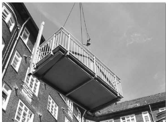
L'élément pour balcon prémonté est transporté à l'aide d'une grue.
