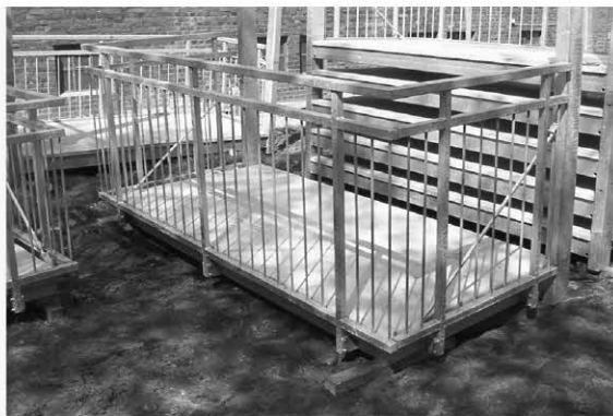
La rambarde et la fixation au mur sont installées: l'élément pour balcon ainsi préfabriqué peut être installé sur le mur.
