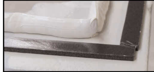
Croquis de la structure portante avec le ruban de montage et la colle, vue de dessus (exemple).
