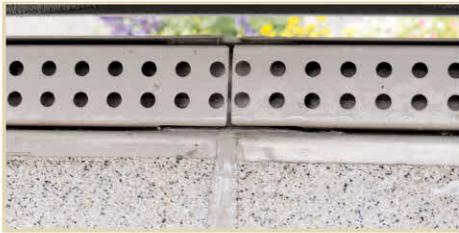
Edelstahlrinne ist durch eingeklebtetes Verbindungselement verbunden.
