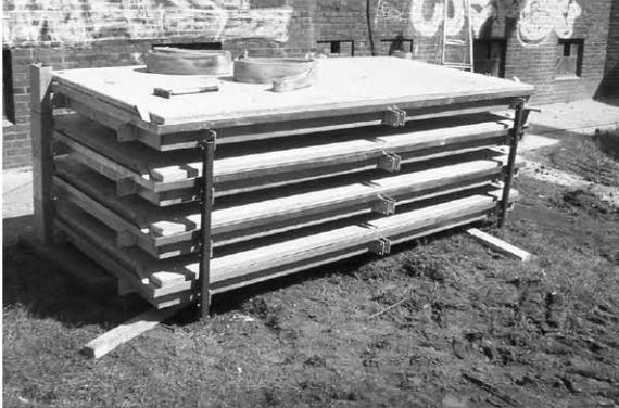
Vormontierte Balkonplatten auf verzinktem Stahlrahmen.
