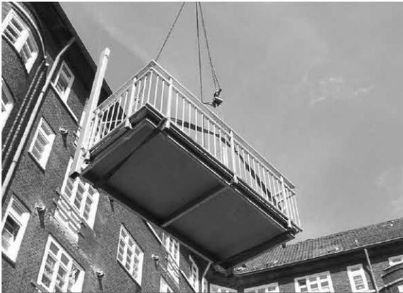
Das vormontierte Balkonelement wird mittels Kran transportiert.
