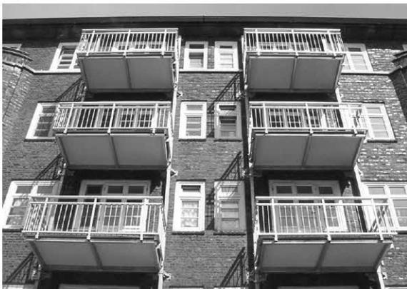
Zwei fertig gestellte Türme – die Balkonplatte aus Mineralit als leichte und dauerbeständige Balkongrundplatte. Diese Lösung sichert eine hohe Verarbeitungsproduktivität gerade bei größeren Bauprojekten.
