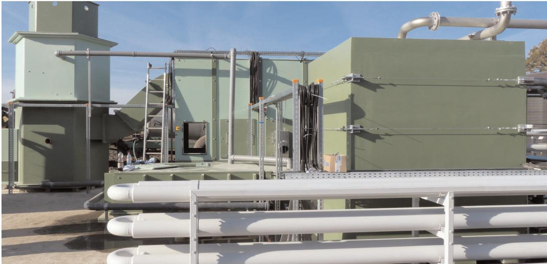
Die Hygienisierung findet (je nach Kategorie) meist vor der Vergärung durch ein einstündiges Erhitzen auf 70 °C statt. Es muss sichergestellt werden, dass kein Substrat über Kurzschlussströmungen unzureichend hygienisiert wird.
