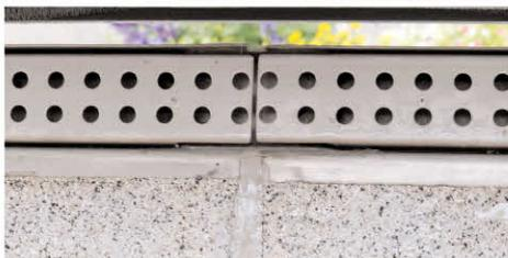
le caniveau de drainage est relié par l'élément de liaison collé
