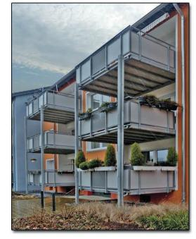
In den Stärken 20, 25 und 35 mm sind die Balkonplatten mit einer **allgemeinen bauaufsichtlichen Zulassung** (Z-10.9-47 | bis 2023) erhältlich. Bei individuellen Abweichungen kann je nach Bedarf auch eine Zustimmung im Einzelfall erwirkt werden.
