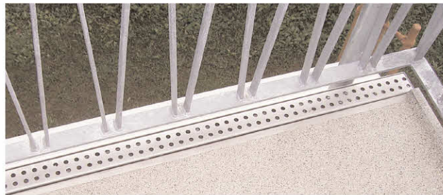
Integrierte Entwässerungsrinne an der Außenseite des Balkons.
