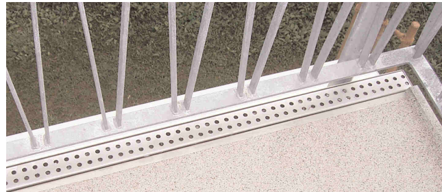
Integrierte Entwässerungsrinne an der Außenseite des Balkons.
