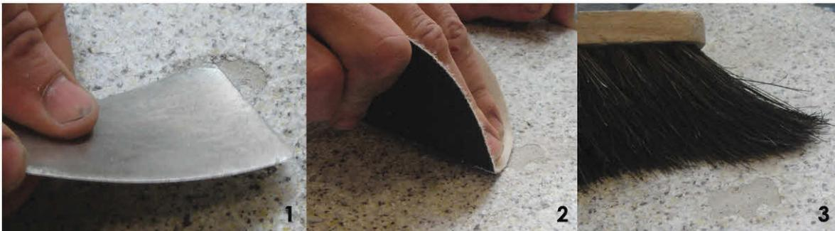
**1** - Zuerst die lose angrenzenden Ränder der vorhandenen Beschichtung mit einem Spachtel entfernen. **2** - Dann die Stelle mit Schleifpapier abschleifen. **3** - Die Stelle mit einem Handfeger vom Staub befreien.
