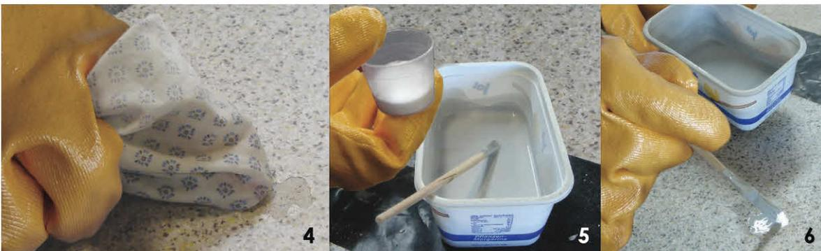
**4** - Reinigung mit Aceton **5** - Anrühren des Harzgemisches. Das grau eingefärbte Harz (**A**) mit ca. 1,5 % bis 2 % Härterpulver (**B**) mischen und gut verrühren. **6** - Das Gemisch mit einem Pinsel auf die Stelle auftragen.
