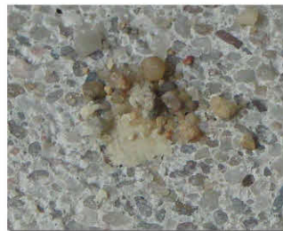
2. In die feuchte Spachtelmasse eindrücken
