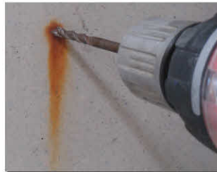
Ausbohren des Pyritkorns
