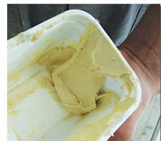
4. Fertige Spachtelmasse und verrühren
