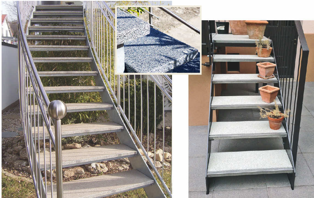
1. Freitragende Treppenstufen
