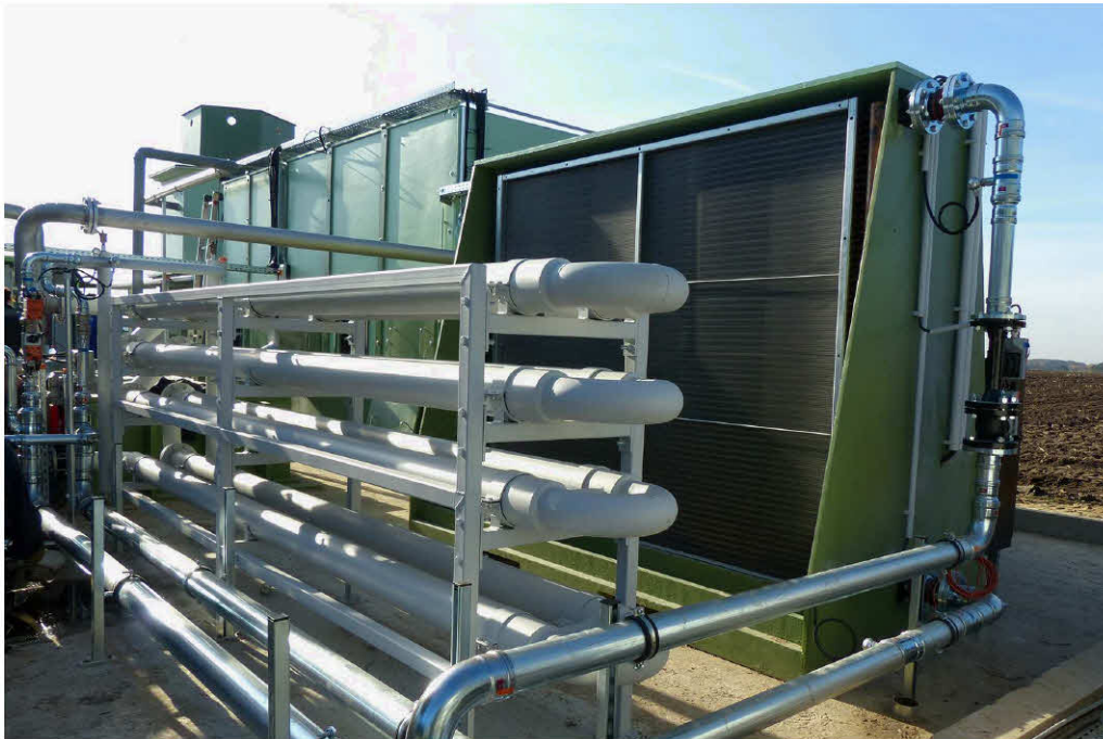
Ansicht Rohrbündelwärmetauscher
