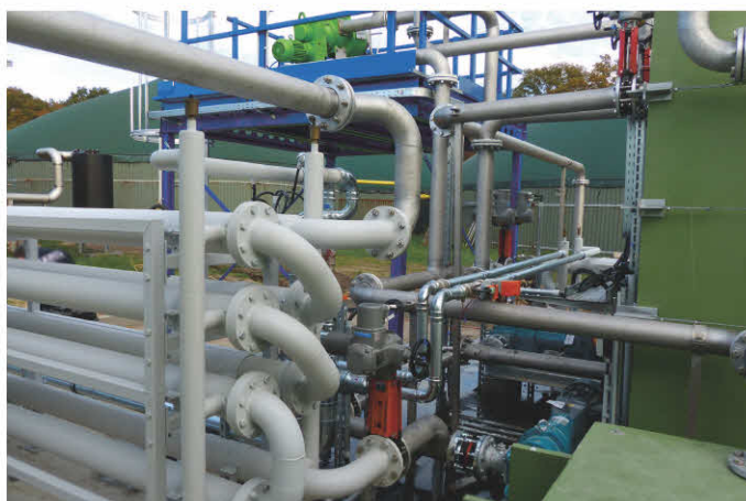
Ansicht Rohrbündelwärmetauscher
