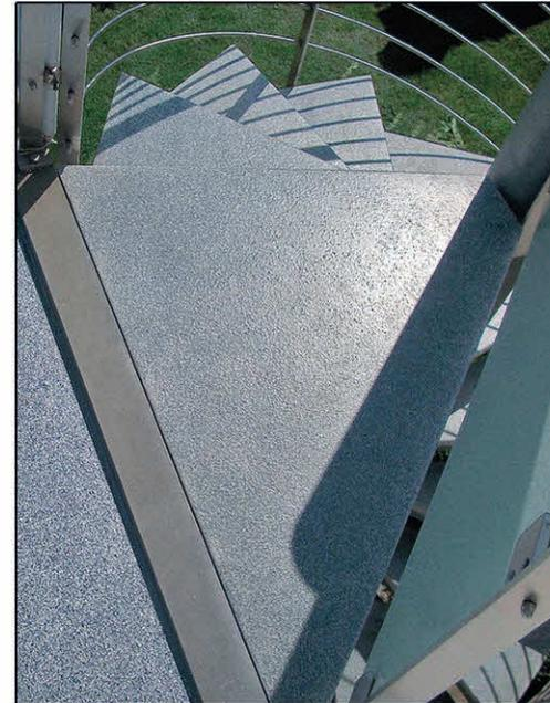
Mineralit - Podestplatten eignen sich **perfekt für den Außenbereich** und können auch in Kombination mit unseren freitragenden Treppenstufen, oder bei Sanierungsvorhaben als vollflächig aufliegender dünnwandiger Plattenbelag verlegt werden.
