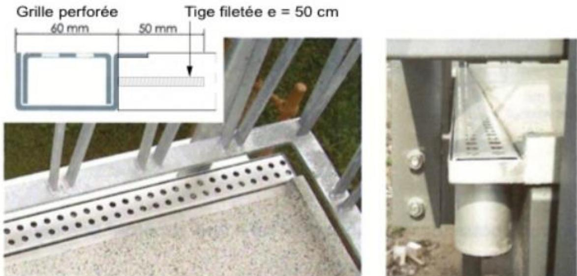
**Figure 20 : Exemple d'évacuation avec caniveau de balcon à grille perforée.**
